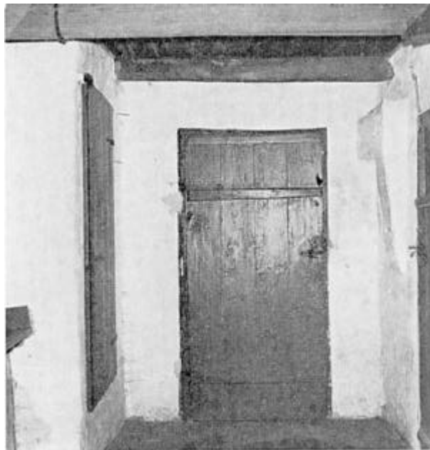
Fig. 8. Den nordlige Del af Bryggerset med Dørene ind til Mælkekammer, Køkken og Aftægtsstue. Alle tre Døre har siddet der siden 1876. Forlængelsen af de to sidstnævnte Døre kunde tyde paa, at de tidligere har haft anden Anvendelse. Røgkanalen kommer fra den lille Bilæggerovn i Aftægtsstuen, den fortsatte tidligere hen til Skorstenen i Køkkenet.
