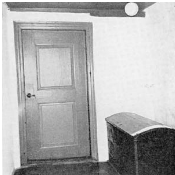
Fig. 5. Østvæggen i Gangen med Storstuedøren, i et Bræt paa Bjælken Træknager til Tøj. I Væggen til Venstre, gaaende helt op i Hjørnet sad tidligere Døren ind til Loftstrappen.
