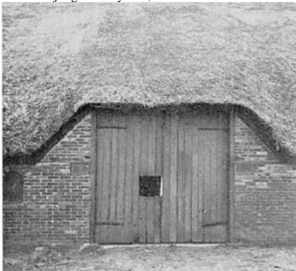
Fig. 10. Døre i den østlige Kørelo. De to rektangulære Vinduer lige under Murremmen er de oprindelige, Jernvinduet til Venstre er nyere.
